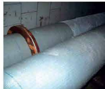
Kondisi pipa setelah dilakukan perkuatan dengan Tyfo® Fibrwrap® System.
