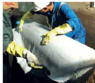
Tyfo® SEH-51A dan Tyfo® SW Epoxy (Wet primer) digunakan untuk meningkatkan kekuatan ikatan pada kondisi pipa yang basah.
